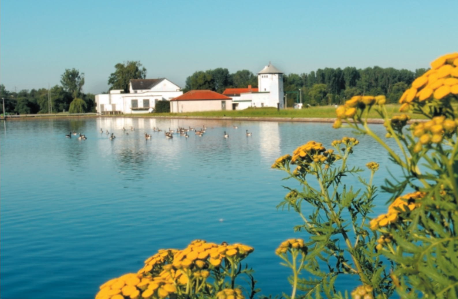
Wasserwerk in Fröndenberg-Warmen an der Ruhr
