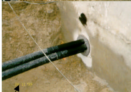
MSH Außenansicht und Schutzrohrbündel im gemeinsamen Rohrgraben
